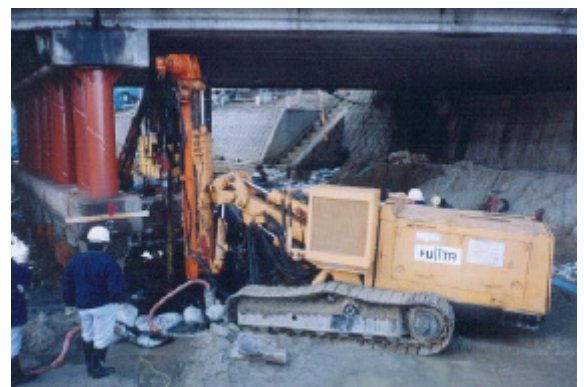
写真 - 1 HMP 施工状況
