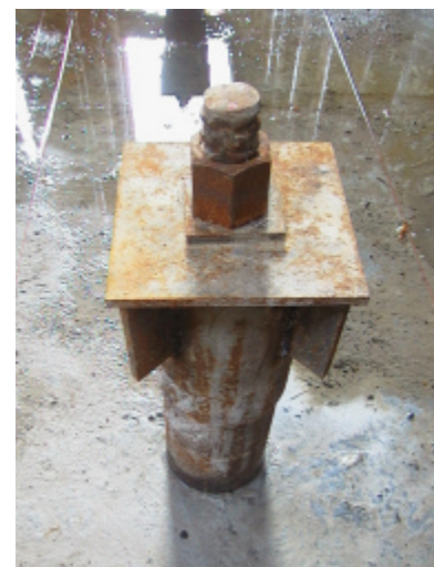
写真 - 2 杭頭処理状況
