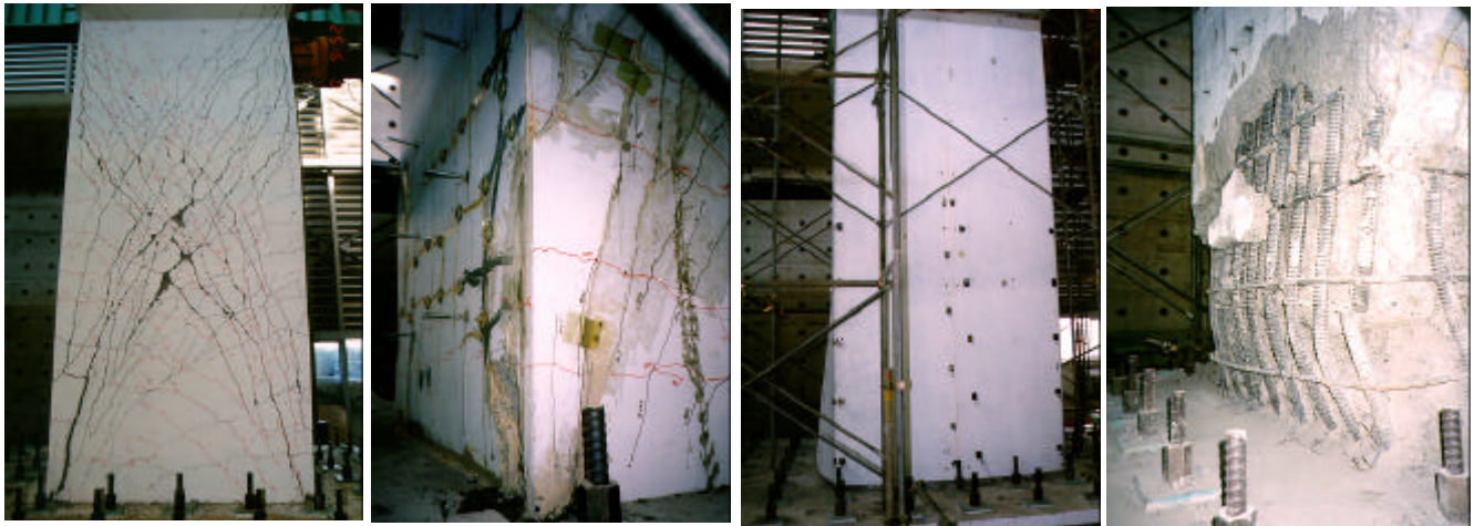
写真 - 1 せん断ひび割れ 写真 - 2 補修状況 写真 - 3 鋼板巻き補強 写真 - 4 補強後実験結果
