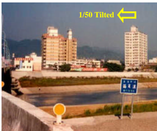
写真-1 軍功橋から見た14階建ての傾斜建物
