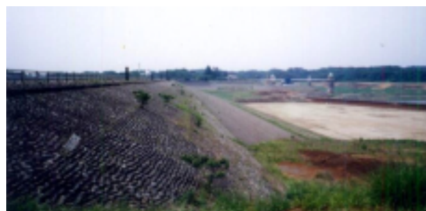
写真-1 着工前の既設構造物
