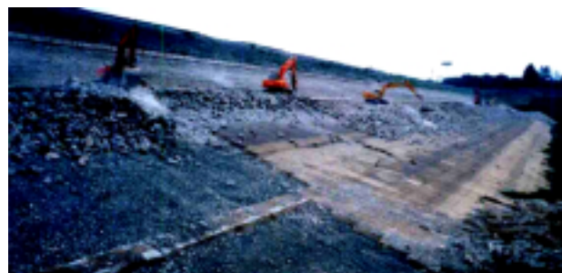
写真-2 既設構造物撤去状況
