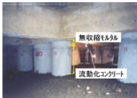
写真 - 1 コンクリート打設完了
