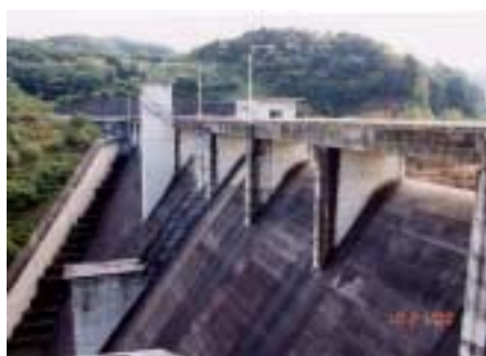
図 2 底部に 500 ガル以上の加速度を受けても何ともなかった賀祥ダム
