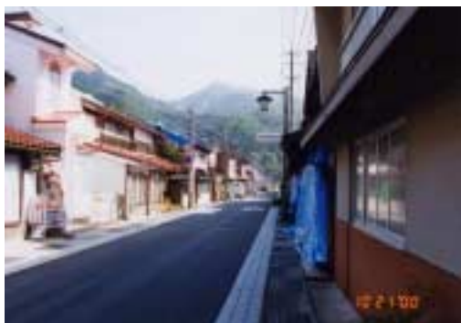
図 1 1400ガルを記録した日野町役場そばの町並み(倒壊家屋は一軒もなし)
