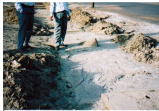
写真-7 液状化による噴砂
