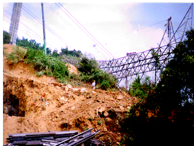
写真-1 倒壊した345kV超高压送電鉄塔(中寮~峨眉間の#203)
