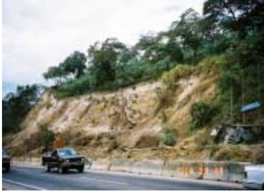
写真-2 Los Chorros における火山礫凝灰岩・火山碎屑物互層斜面崩壊
