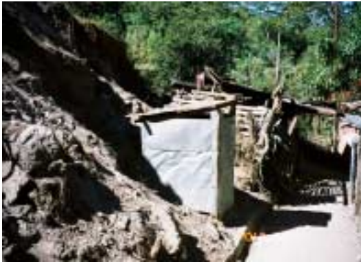
写真-4 Neuva Cuscatlan における火山礫凝灰岩斜面崩壊
