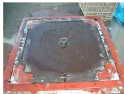
写真1 No.4注入後状況
