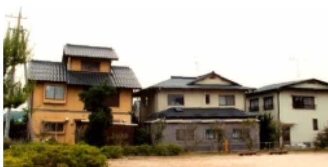
写真-1 安倍彦名団地における液状化による家屋の傾斜被害
