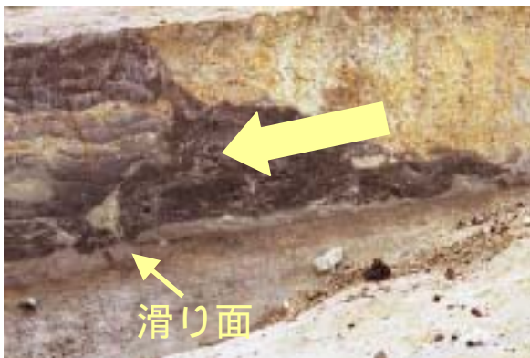
図3 滑り面の様子
