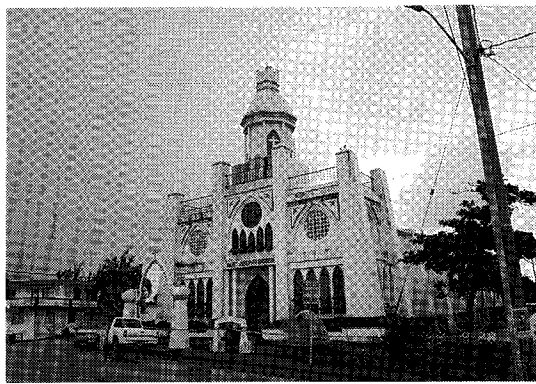
写真—11 十字架が落下したInarajanの教会
