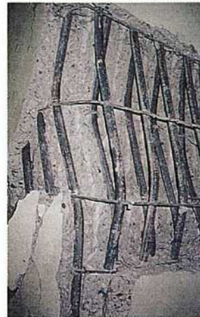
写真-5 中柱の帯鉄筋の効果
