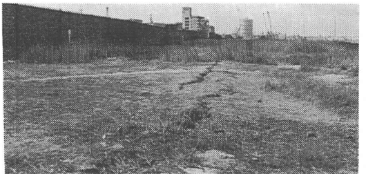
写真-3 高水敷の状況
