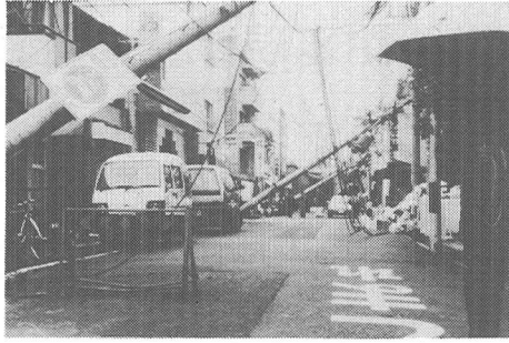
写真-2 電柱の倒壊による街路閉塞の一例
