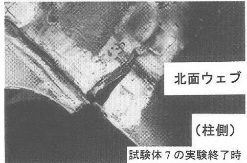
写真-7 損傷状況（試験体6,7）
