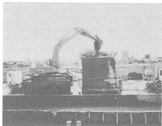
写真-4 解泥船作業状況
