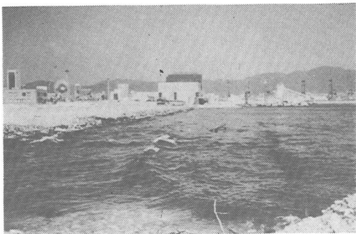
写真-2 岸壁被災状況図
