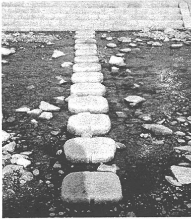
写真-2 渡り石と階段護岸(住吉川)
