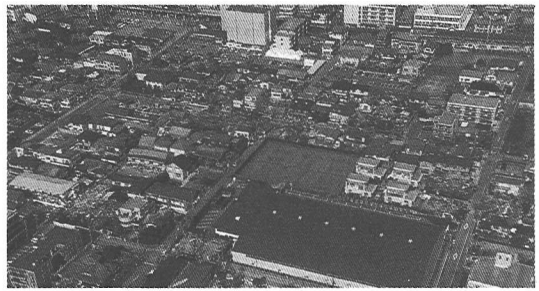
図-4 空撮画像の例 (木造建物の被害判読地域)
