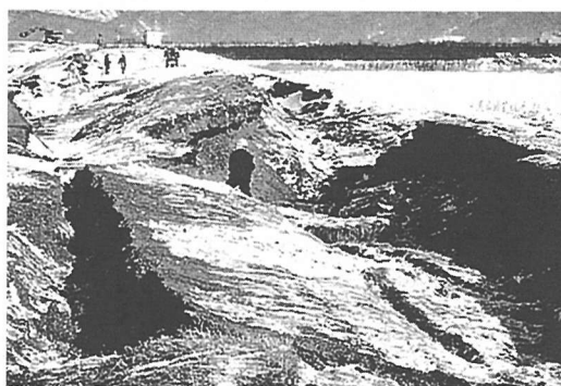
写真-3 十勝川堤防の被災(右岸 統内地先)
