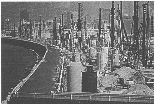
写真-8 淀川における地盤改良施工状況 (左岸西島地先)
