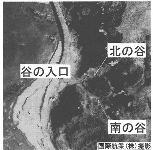
図-5 谷周辺の航空写真(国際航業撮影)
