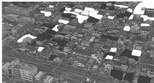
図-8 図-7の目視判読 7) と地上調査 21), 22) の結果。黒：倒壊建物，白：全壊建物を表す。
