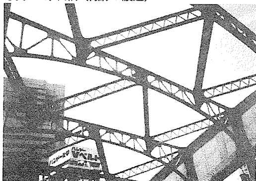
写真4 永代橋の対傾構(撮影:渡辺)
