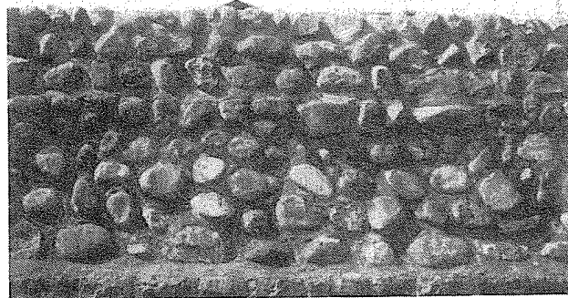
写真一3（左）本町の石積護岸－野面 石乱層練積（撮影：昌子住江）
