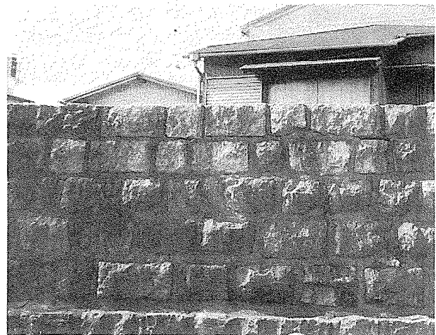
写真—2 本町の石積護岸—間知石 整層積 (撮影：昌子住江)
