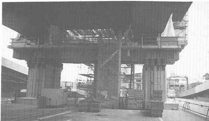
写真-3 大口径桁受けベント
