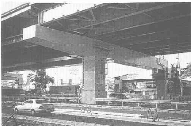
写真-5 P170 橋脚復旧後の状況
