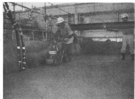
写真-2 プレートコンパクタによる締め固め状況(例)
