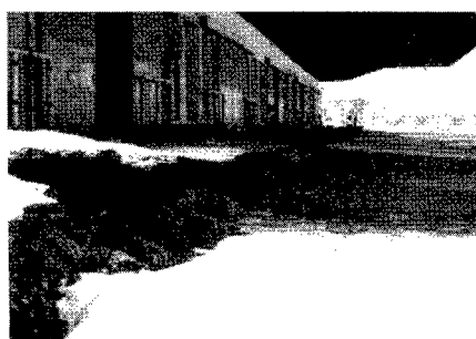
写真4 釧路沖地震の上屋前エプロンの沈下 (釧路港東港区漁業埠頭)
