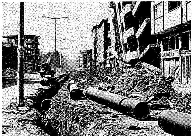
写真-6 アダバザール市における上水道管路の復旧工事
