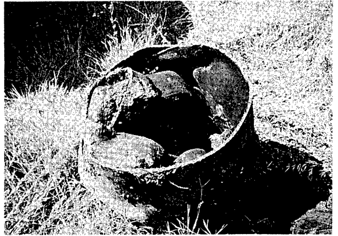
写真-2 断層を横切る水道管路の座屈 (28インチ鋼管)
