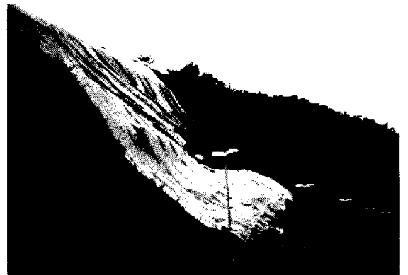
写真-1 斜面すべり崩壊事例(埔里)
