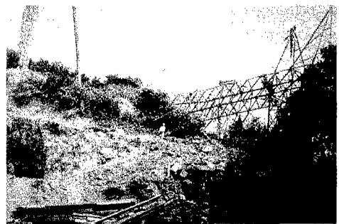
写真-1 倒壊した345kV超高压送電鉄塔(中寮～峨眉間の#203)
