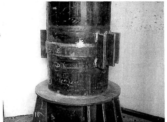
写真1 補剛板溶接部
