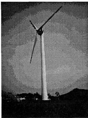
写真-1 風力発電設備の外観図
