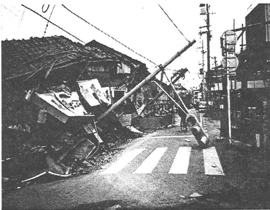
図1.1 倒壊建造物による道路の閉塞
