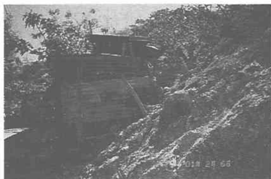
写真-4 Neuva Cuscatlan における火山礫凝灰岩斜面崩壊
