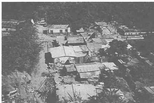
写真-5 Tepecoyo 斜面崩壊と倒壊家屋
