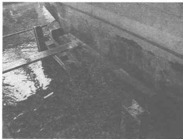
写真-2 一次コンクリート打設
