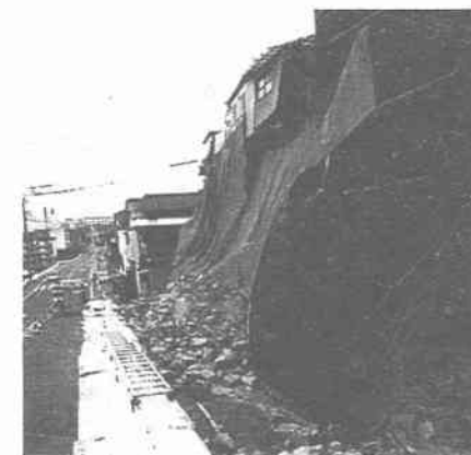
⑦呉市宮原の余震で崩壊した宅地
