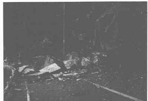
図-3 国道432号線での落石による被害
