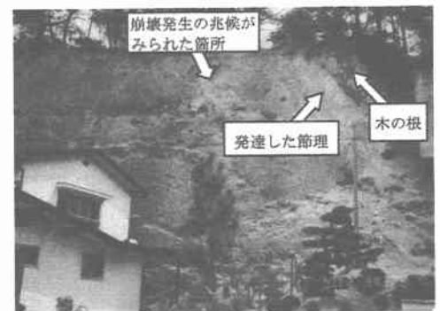
写真-1 岩国市錦見における斜面崩壊
