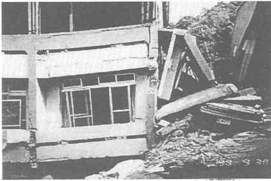
写真-1 明瞭な鉛直変位が現れた共同住宅の端部
