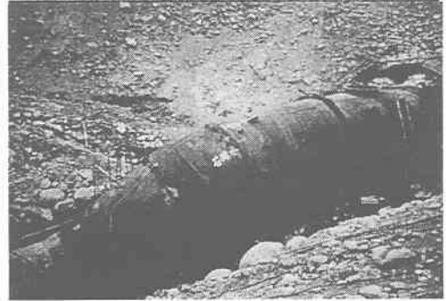
写真-6 被害を受けた導水トンネルの復旧の様子
