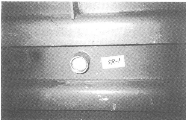
写真-6 注入翌日のグラウトホール内部の状況
