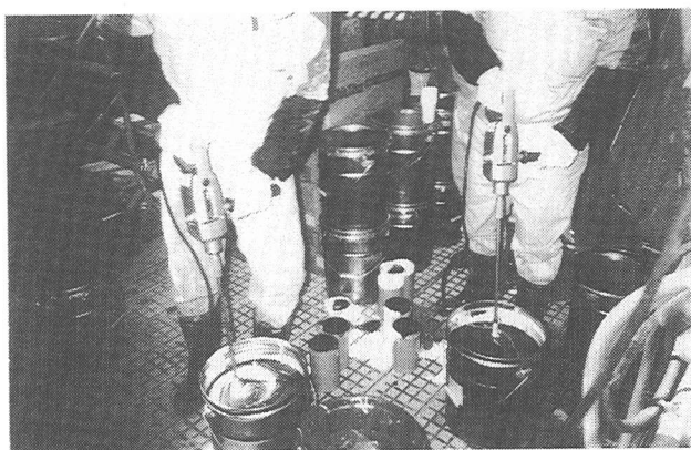
写真-3 電動ミキサーによる免震材のミキシング状況
