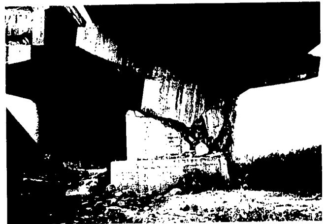
写真-5 新橋のP2橋脚の被害
