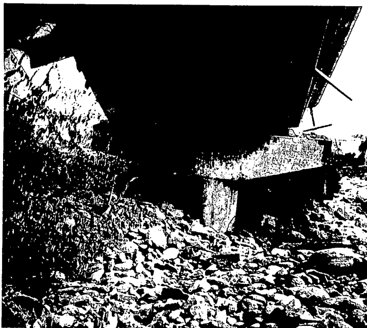
図-6 B3橋脚損傷状況写真
