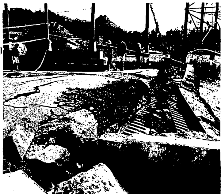
図-4 橋台部損傷状況写真
