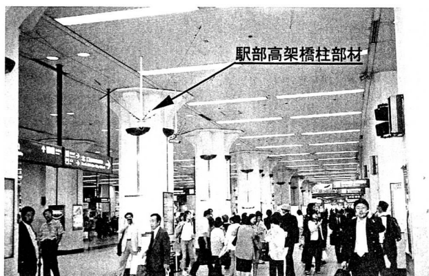
写真-2 補強想定構造物（その2）
