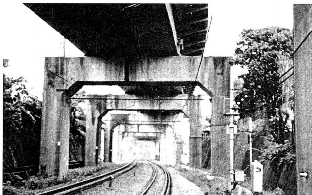
写真-1 補強想定構造物（その1）
