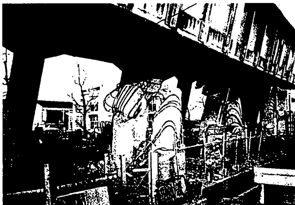
図-9 阪水高架橋被災状況
