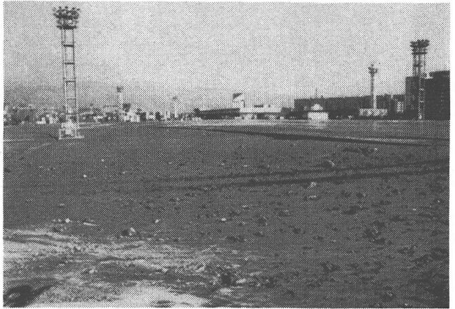
写真1 兵庫県南部地震による ポートアイランド港湾部における噴砂
