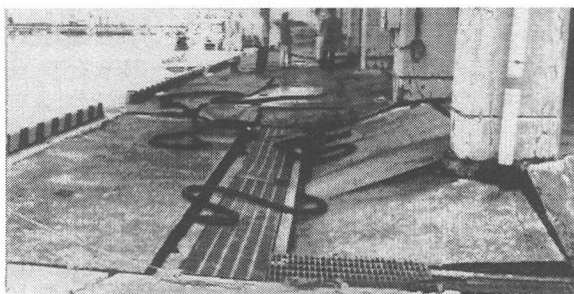
阿久根漁港新港物揚場岸壁とエプロン
