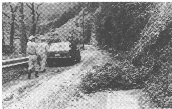
斜面崩落(国道504号線中ノ屋敷)
