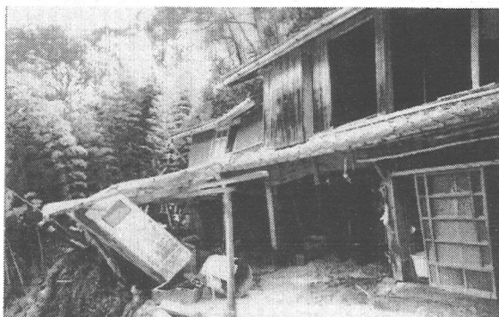
裏山崩落による家屋の被害(国道504号線沿い泊野)
