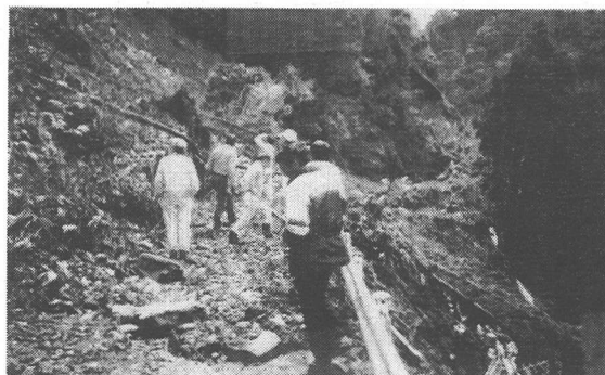
国道504号線中ノ屋敷～平八重間の大規模斜面崩落
