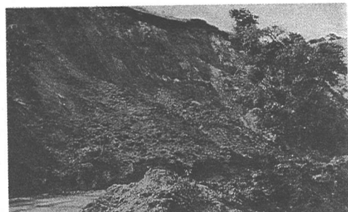
写真-1 斜面崩壊による崩土が道路を覆った例
