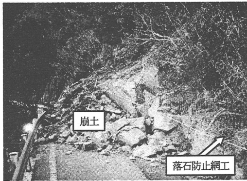
写真-4 東和町油宇における大規模な岩盤崩落
