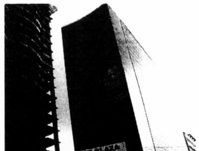
図-4 レベントプラザ (地下5階地上14階)
